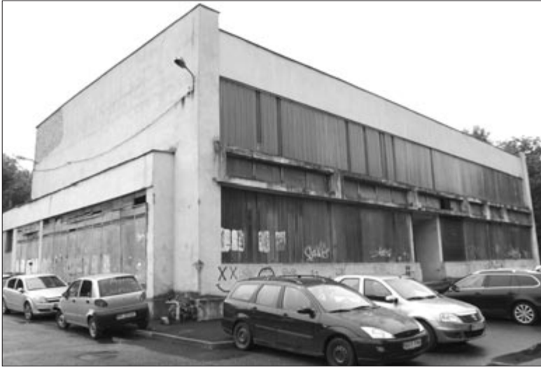
A Csalhó utcai kazánház
