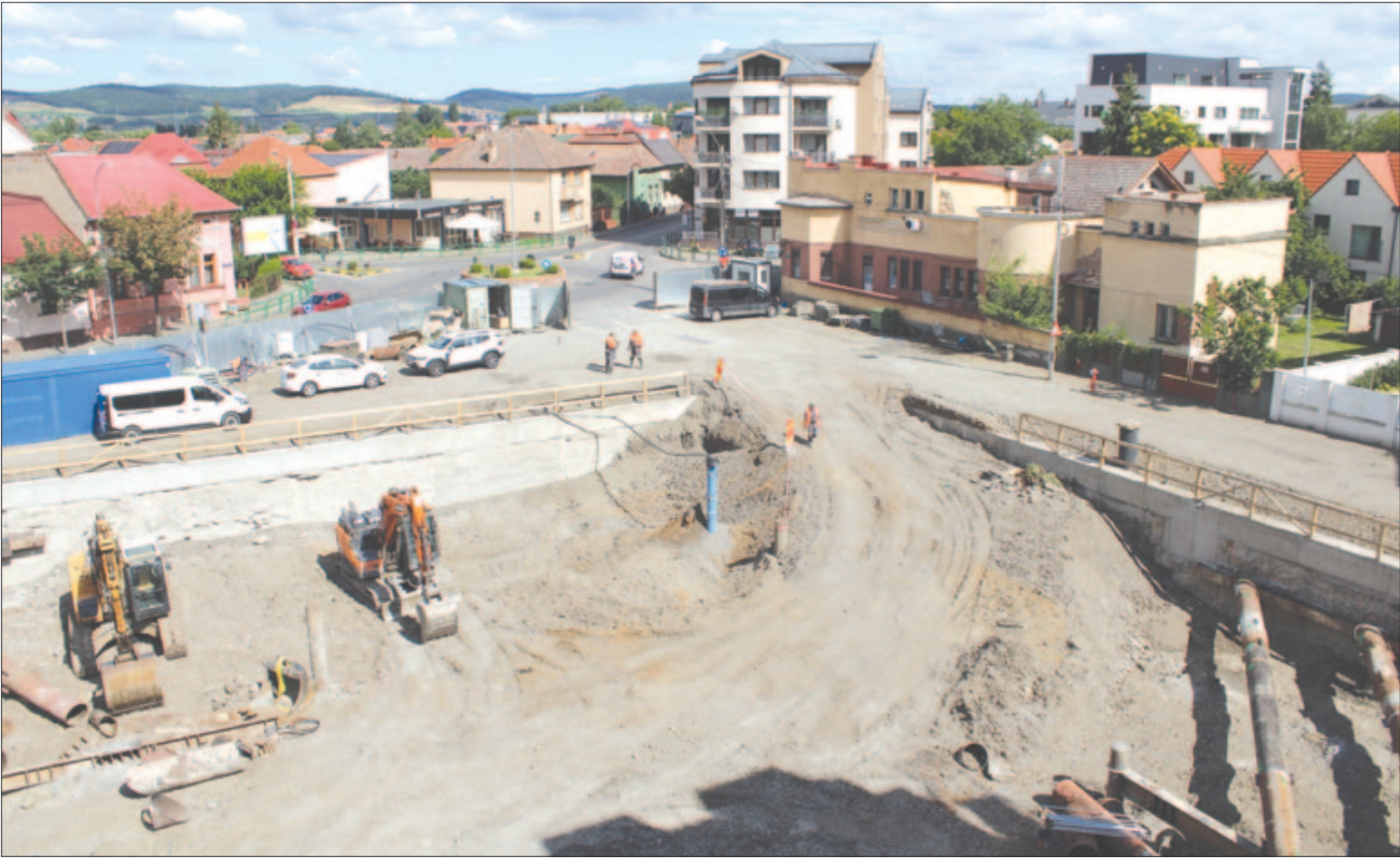
Az épülő főtéri mélygarázs
