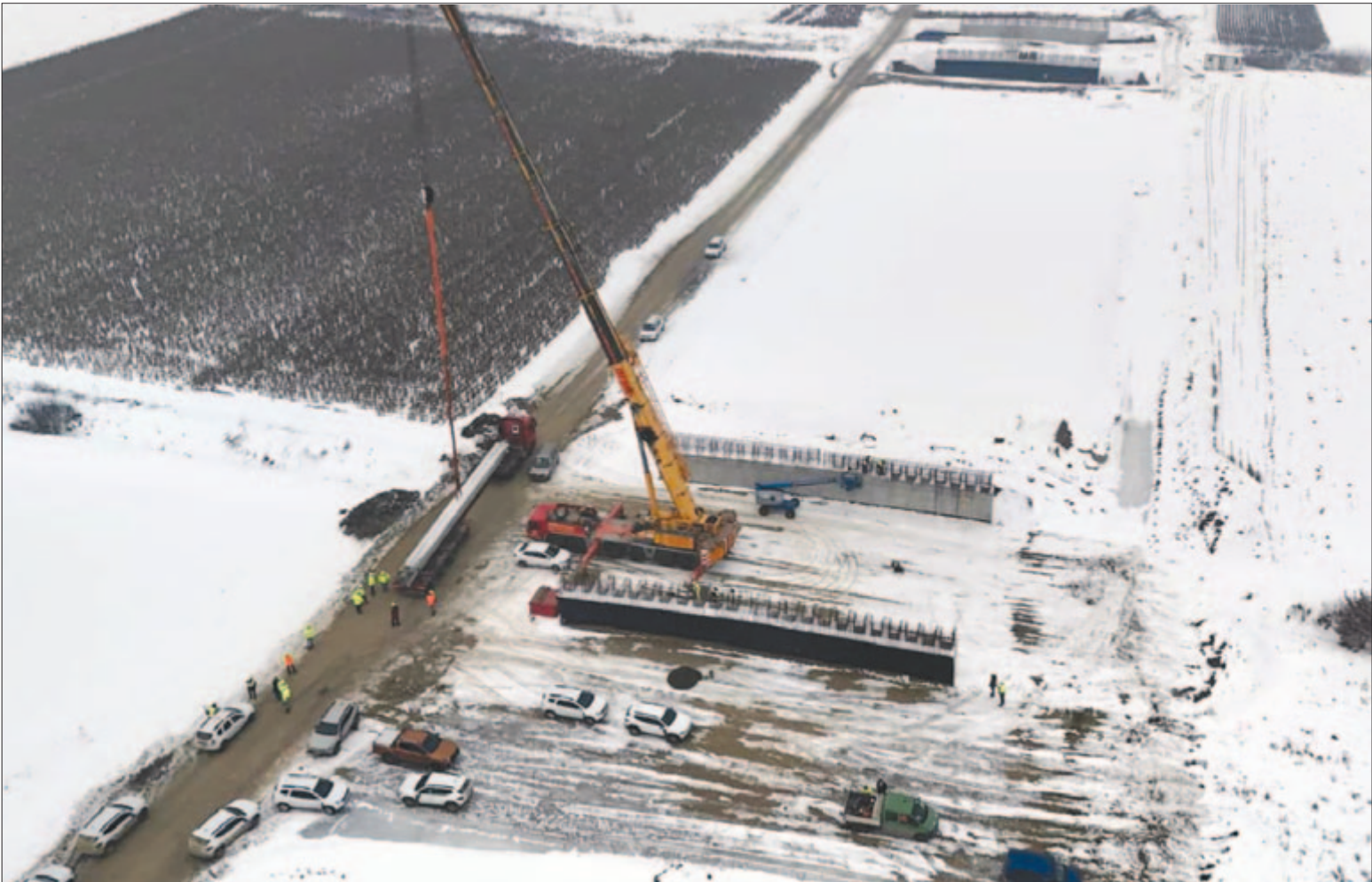
A napokban elhelyezték az első hatalmas vasbeton gerendákat
