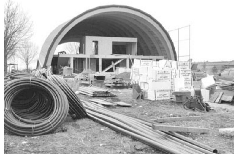
Jól halad az uszoda építése, már az idén átadnák
