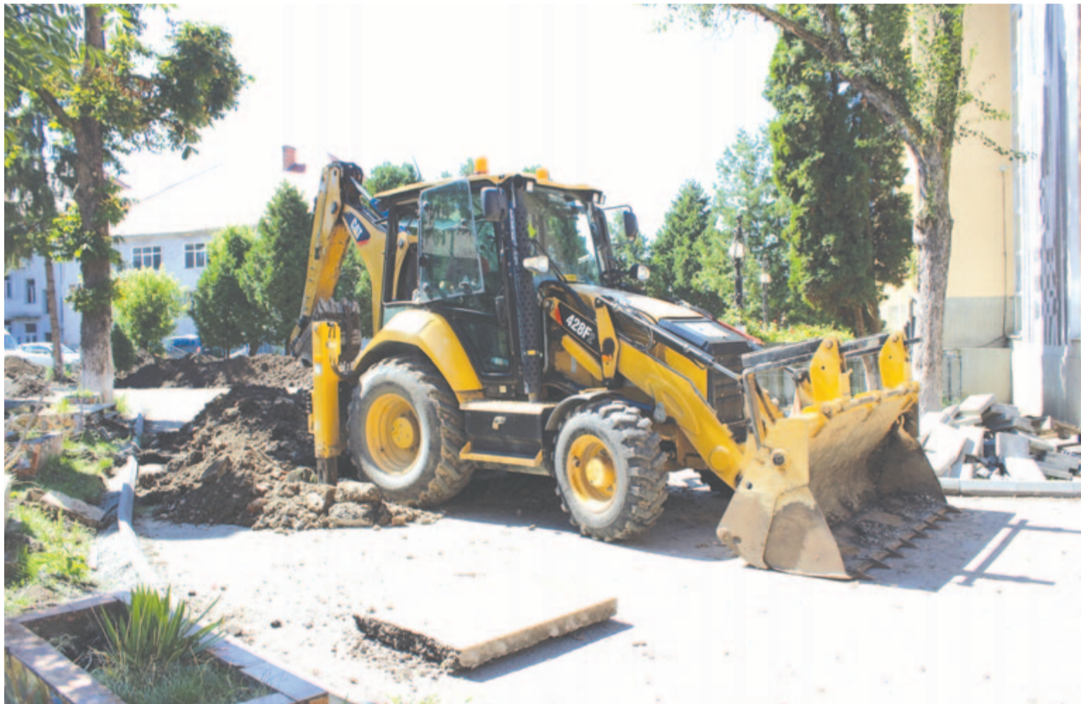
Járdafelújítás a Constantin Brâncuș Szakközépiskolában
