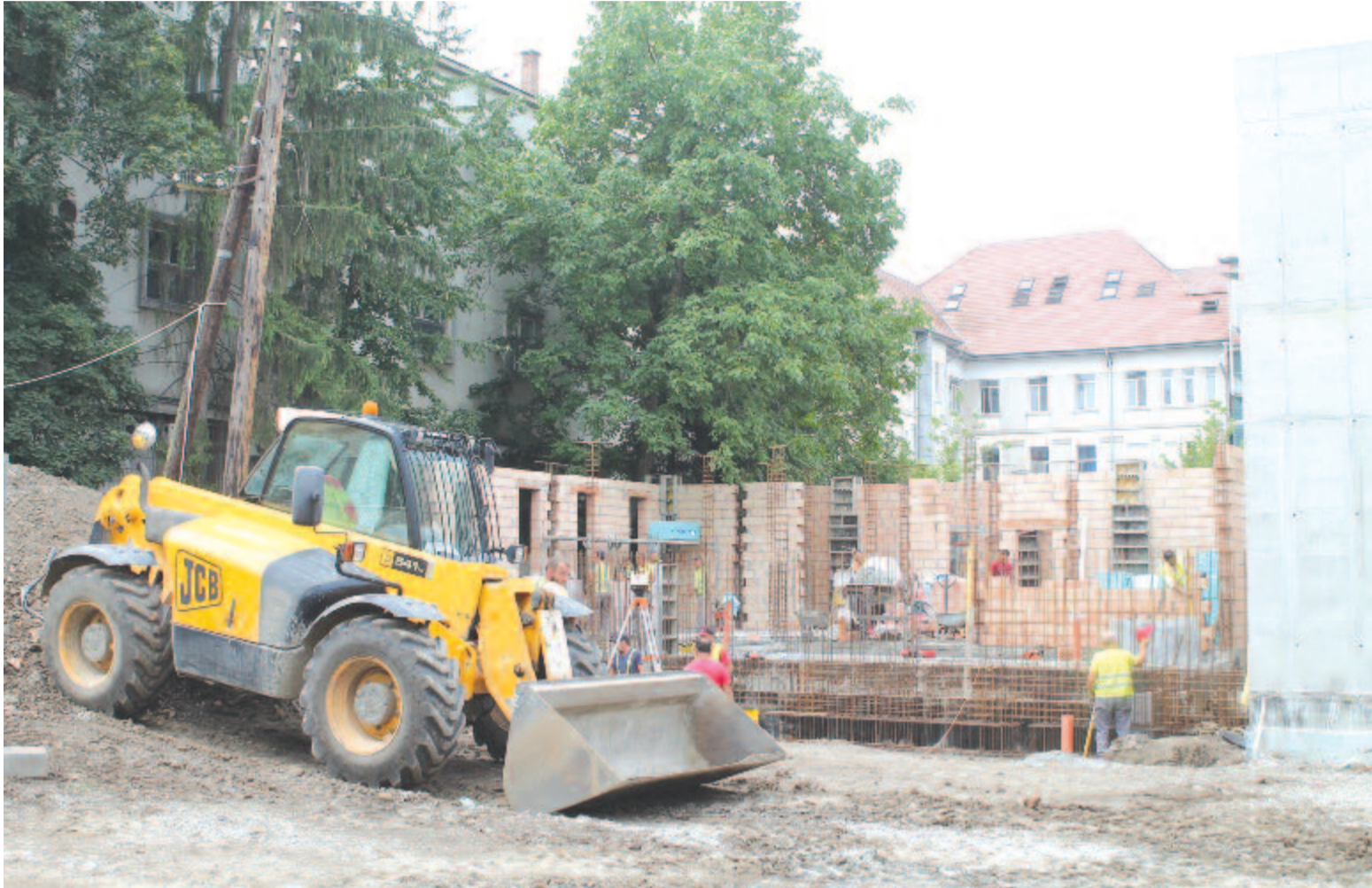
Készül az új sugárterápiás készülék beüzemeléséhez szükséges bunker
